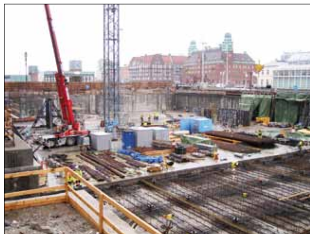
P-huset Baggers Plats - Här ser man tydligt de gjutna bottenplattorna och pågående armering.
