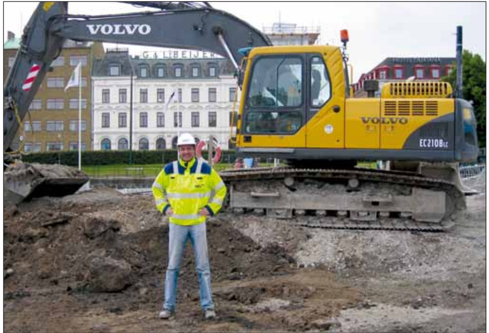
Nu används små grävmaskiner för att sanera marken där en bensinmack låg förr. Det stora schaktarbetet kommer att genomföras med maskiner som har större grävkapacitet, säger NCC:s Peter Sindt.
