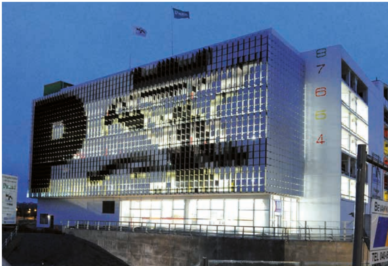
Parkering Malmö har valt att satsa på hög kvalitet i material eftersom det, förutom en fräschare känsla, även skapar lägre underhållskostnader.
