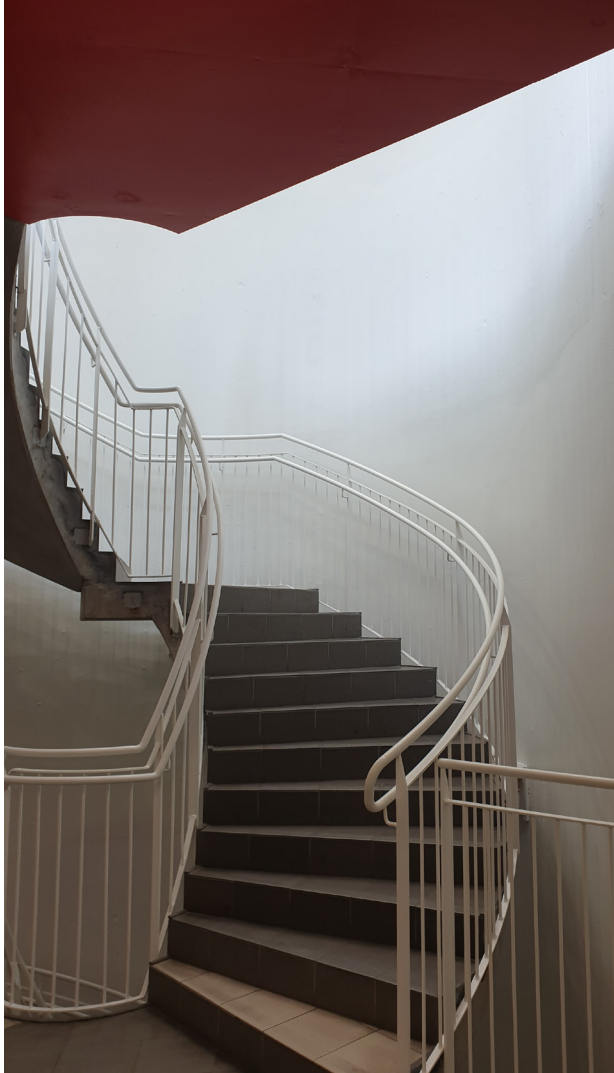
Uppfräschat trapphus i P-huset Baggers plats.
